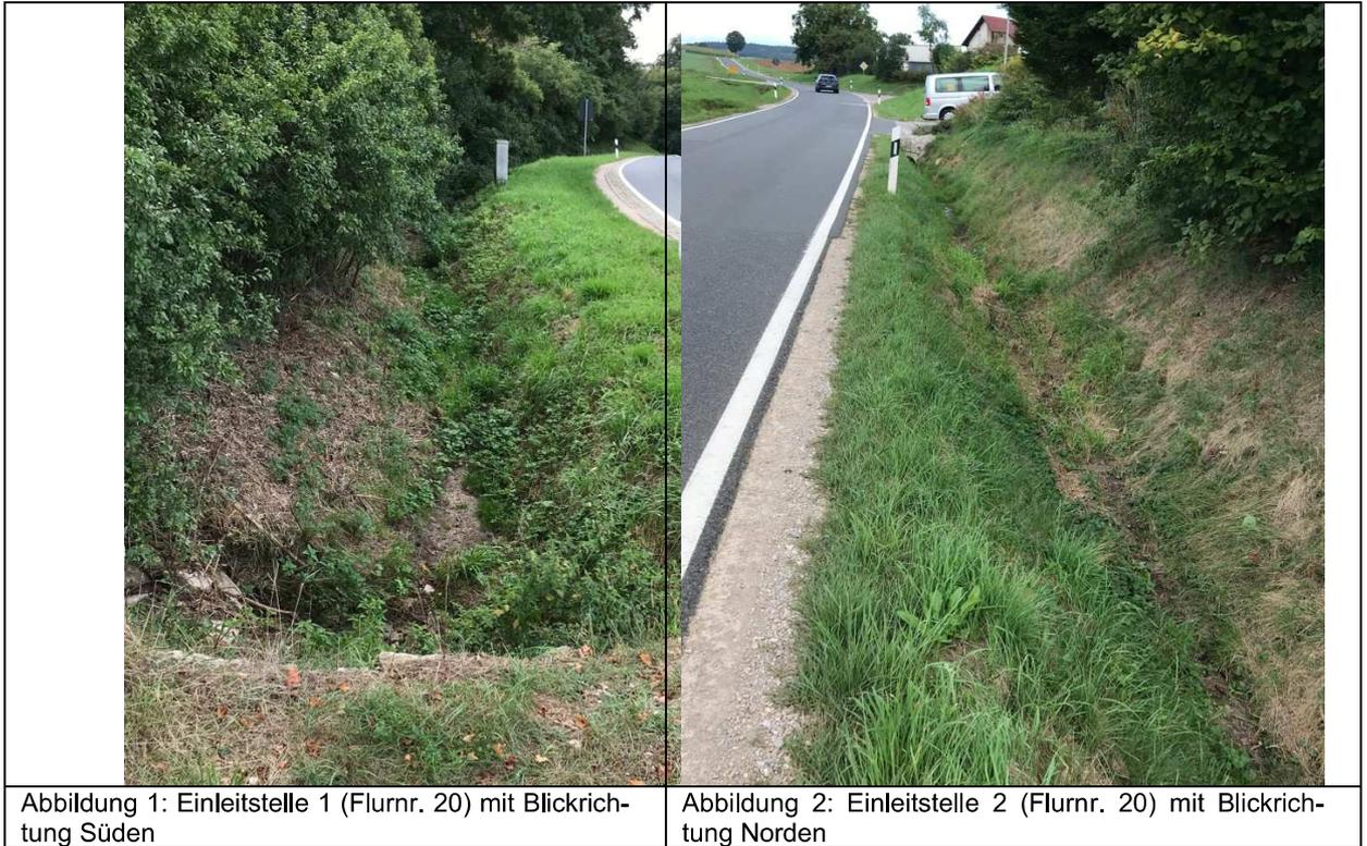
Beide Bilder zeigen die jeweiligen Einleitstellen mit dem Verlauf des Straßenentwässerungsgrabens von der NM 26 zur Versickerung des Niederschlagswassers.
